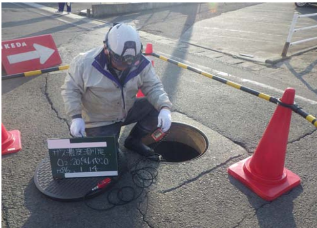
鉄筋探査状況
